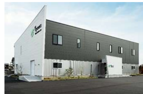
岡山本社・ 医療機器工場
