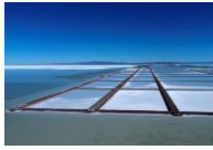
ボリビアのウユニ塩湖にあるリチウム抽出のための蒸発プール（2022 年 3 月）＝ロイター
